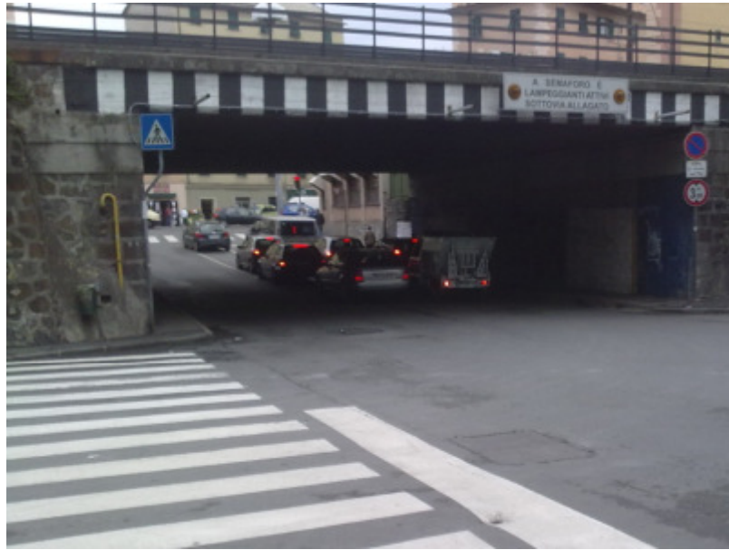
Figura 4.7. Il sottopasso di Brin; si osserva bene l'avvallamento stradale che si presta a diventare sede di un severo ed insidioso allagamento
