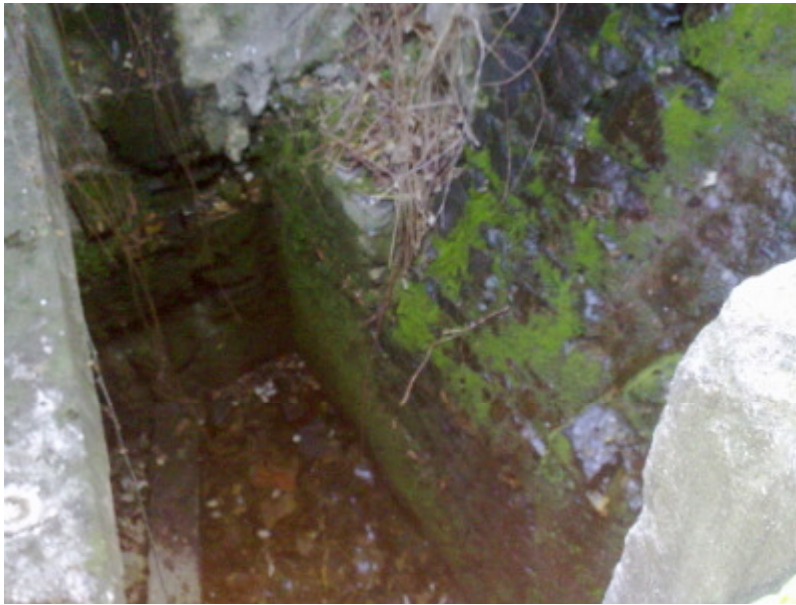
Figura 4.5. Particolare dell'ingresso in tombino del rio presente nel Campasso
