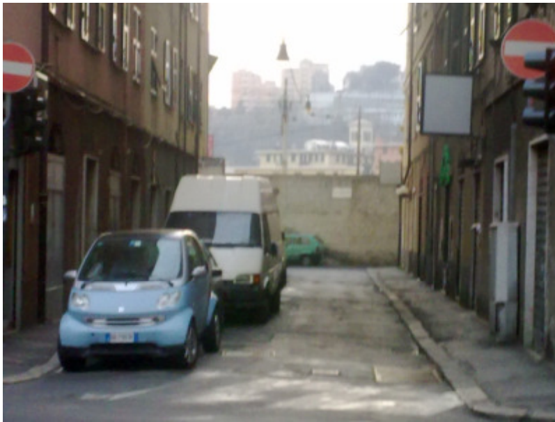
Figura 4.2. Il muraglione che sostiene il terrapieno della ferrovia ad ovest di Piazza Masnata
