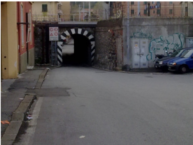
Figura 4.9. Il piccolo sottopasso che collega Via Fillak all'argine del torrente Polcevera. Al suo sbocco la strada è leggermente in salita
