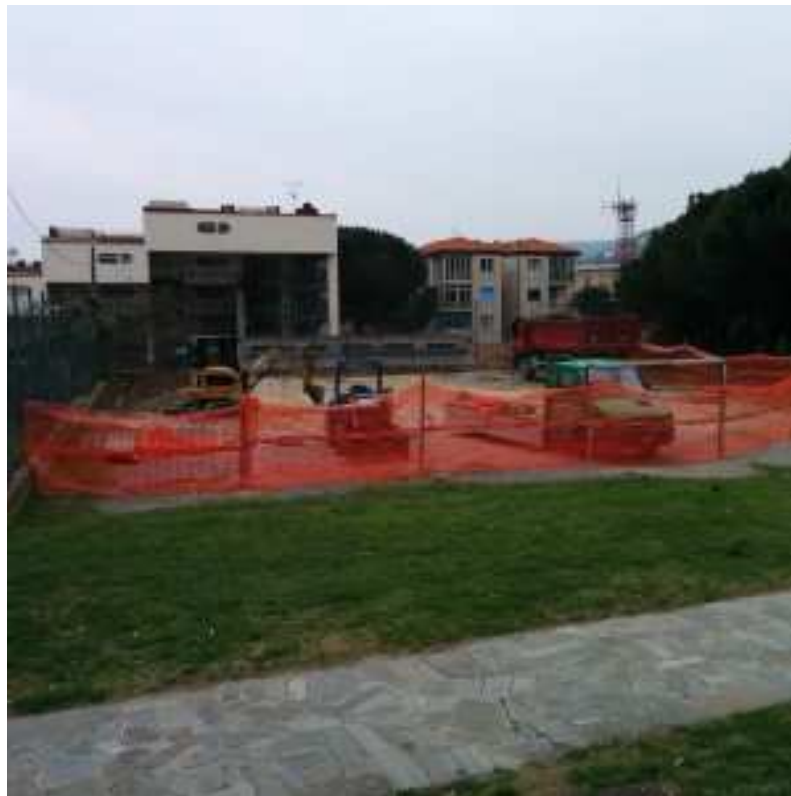
(Parco Monticello, inizio dei lavori al campetto)
